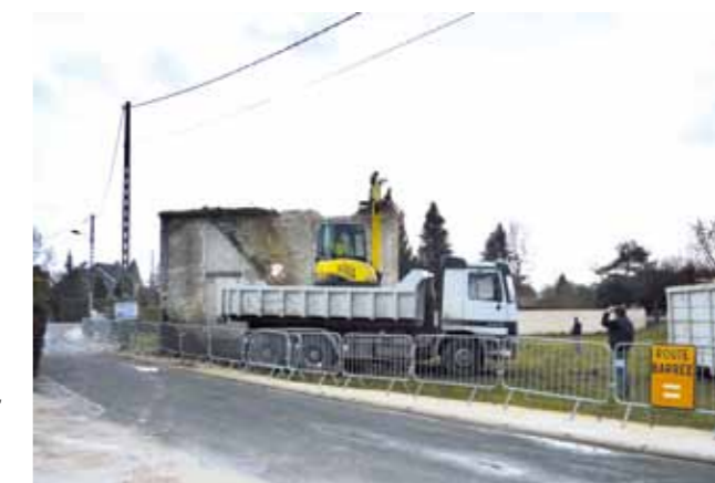
Début des travaux sur le parking
