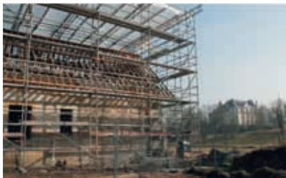
Travaux sur la Ferme suisse
